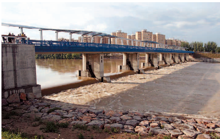
EL AZUD, ABIERTO PARA DAR PASO A LA PEQUEÑA CRECIDA DE JUNIO DE 2008, Y ESCOLLERA DE BLOQUES
