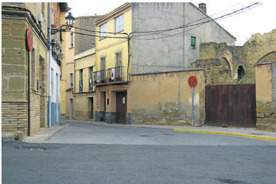
TAMBIÉN PROTESTARON POR EL PROYECTO DE ASFALTADO DEL CASCO VIEJO, CON NUMEROSAS DEFICIENCIAS. SE PUEDEN OBSERVAR CRESPONES NEGROS EN LAS VENTANAS
